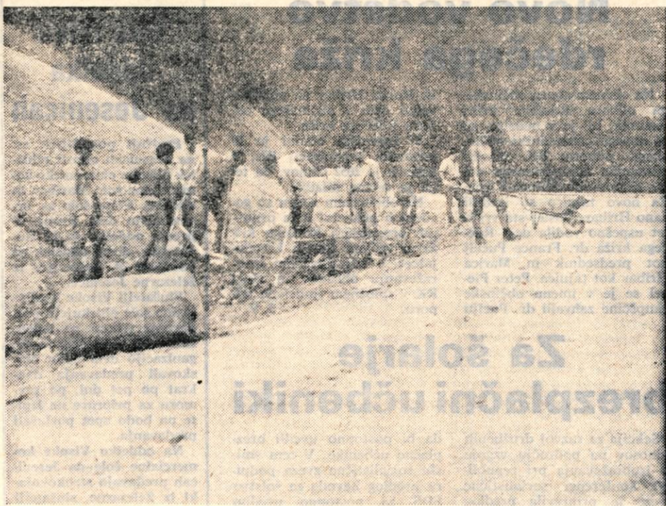
REKONSTRUKCIJA CESTE KRNICIA—POKLJUKA — Ta mesec je bila končana cesta od Zatrnika. Cesta je dolga štiri kilometre, široka pa šest metrov. Rekonstrukcijo sta financirala GG Bled in občinska skupščina, zemeljska in vsa druga dela pa so opravili pripadniki JLA — Na sliki: Zadnja dela pred dokončno ureditvijo. — Foto: R. Knežević
