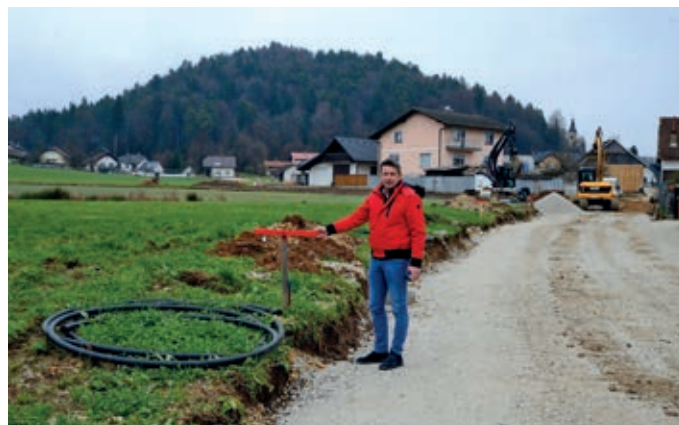
»V Utiku gredo dela po načrtovani časovnici, fekalna kanalizacija bo položena do konca leta in nato sledijo preostala dela.«
