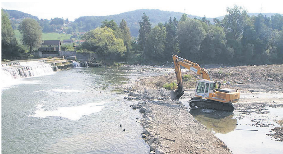
Podvinski jez, od katerega je odvisna poplavna varnost dela Pariželj in Polzele, bo dobil novo, varnejšo podobo.
