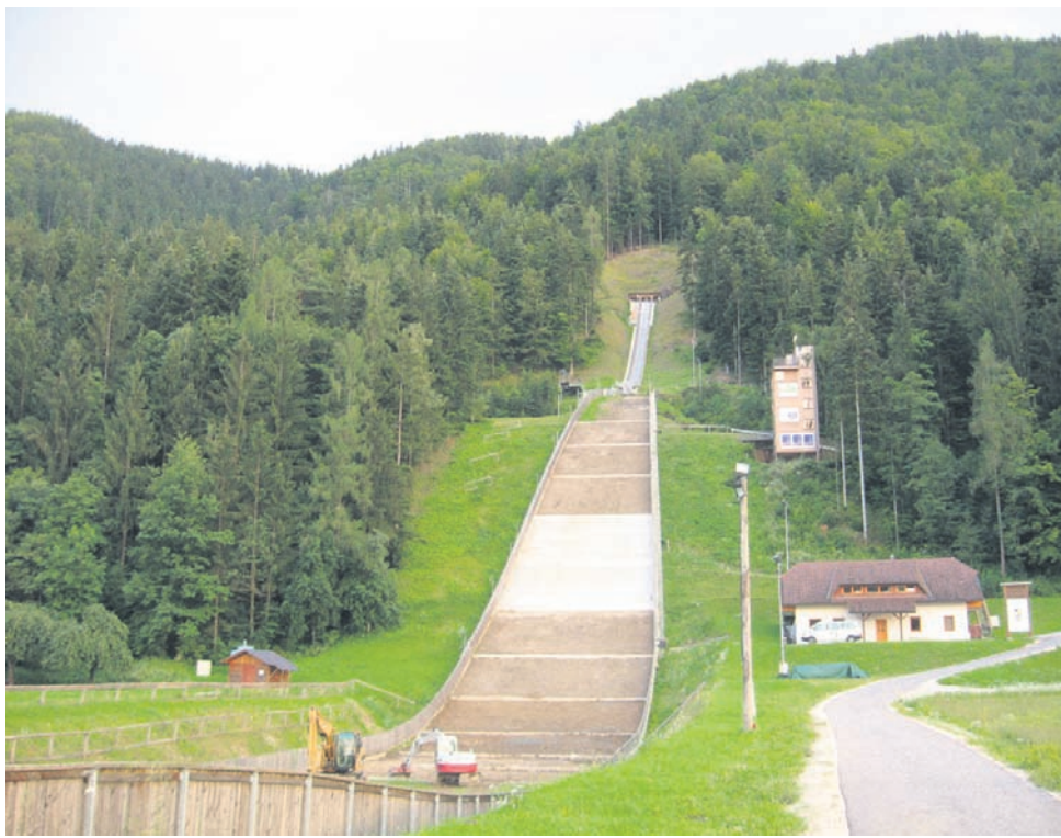
Priprave na plastifikacijo skakalnice na Ljubnem. Gradbišče je nastalo že prejšnji mesec.
