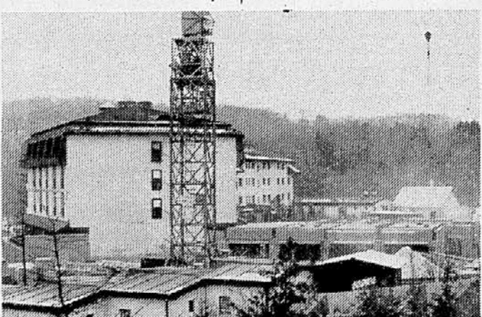
HITJO PRI ZIDAVI PRIZIDKA – Delavcem je vreme zelo naklonjeno, zato gre pri gradnji prizidka v Šmarjskih Toplicah vse po načrtih. Do konca leta naj bi prizidek že bil pod streho. (Slika: S. D.)
