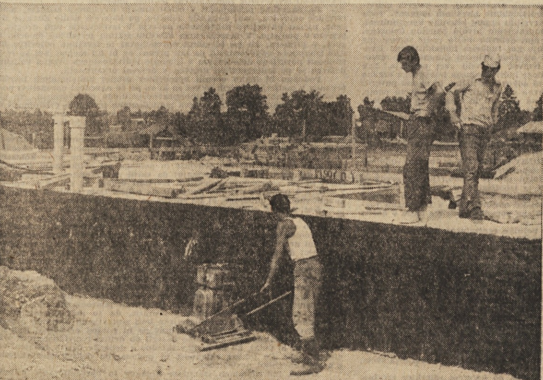
Se malo in temelji s kletjo bodo gotovi. Potem bodo prišli »marlesovci« in iz elementov sestavili hišo
