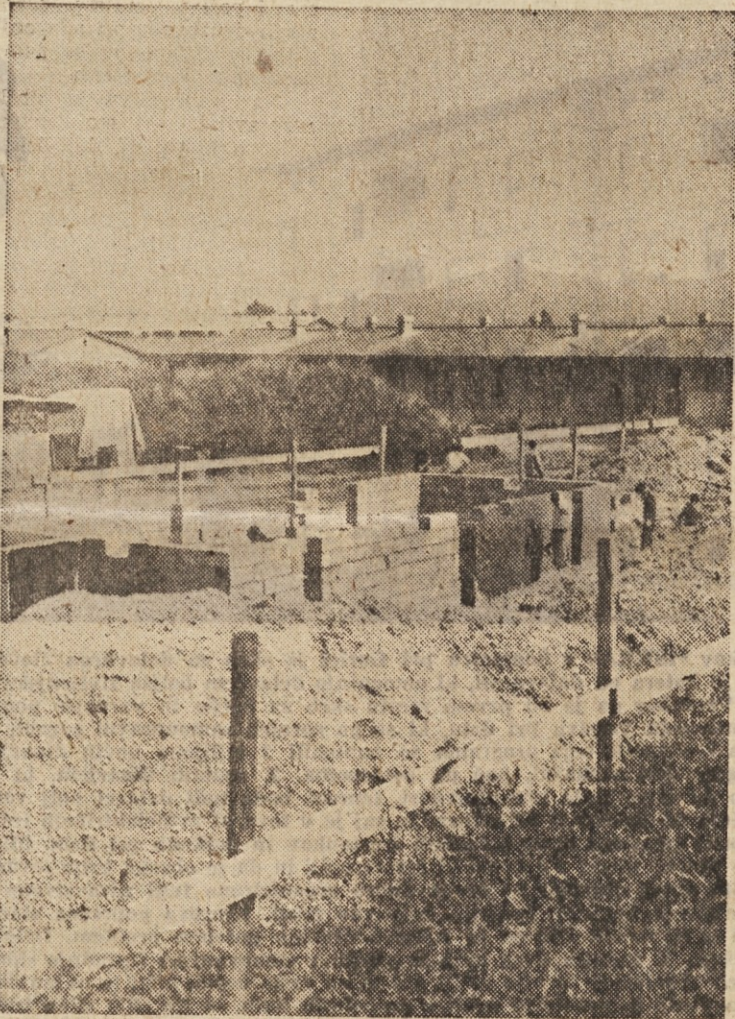
Druga etapa izgradnje naselja MS 17 se je že začela. Gradbena podjetja kopljejo jame in postavljajo temelje
