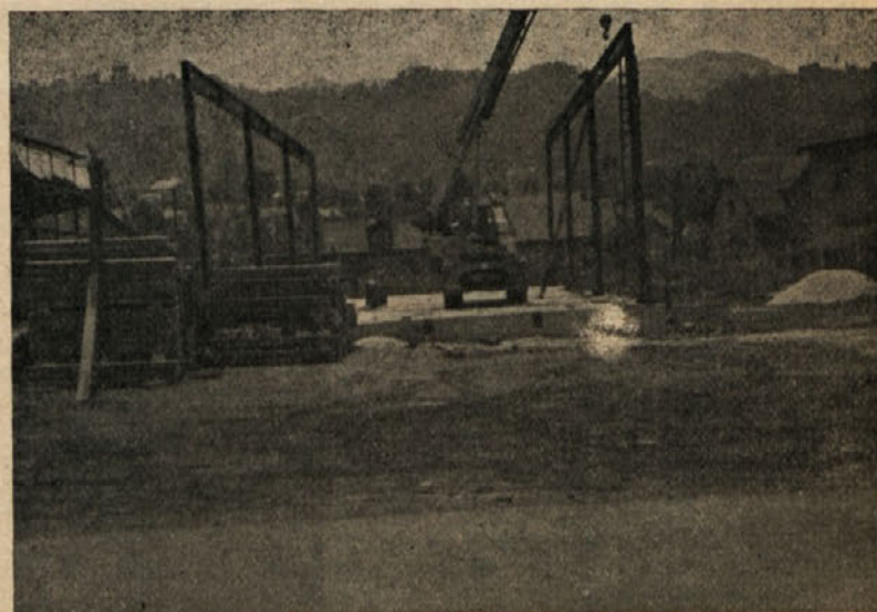
Temelji in začetek gradnje obrata za proizvodnjo ofsetnih plošč.
