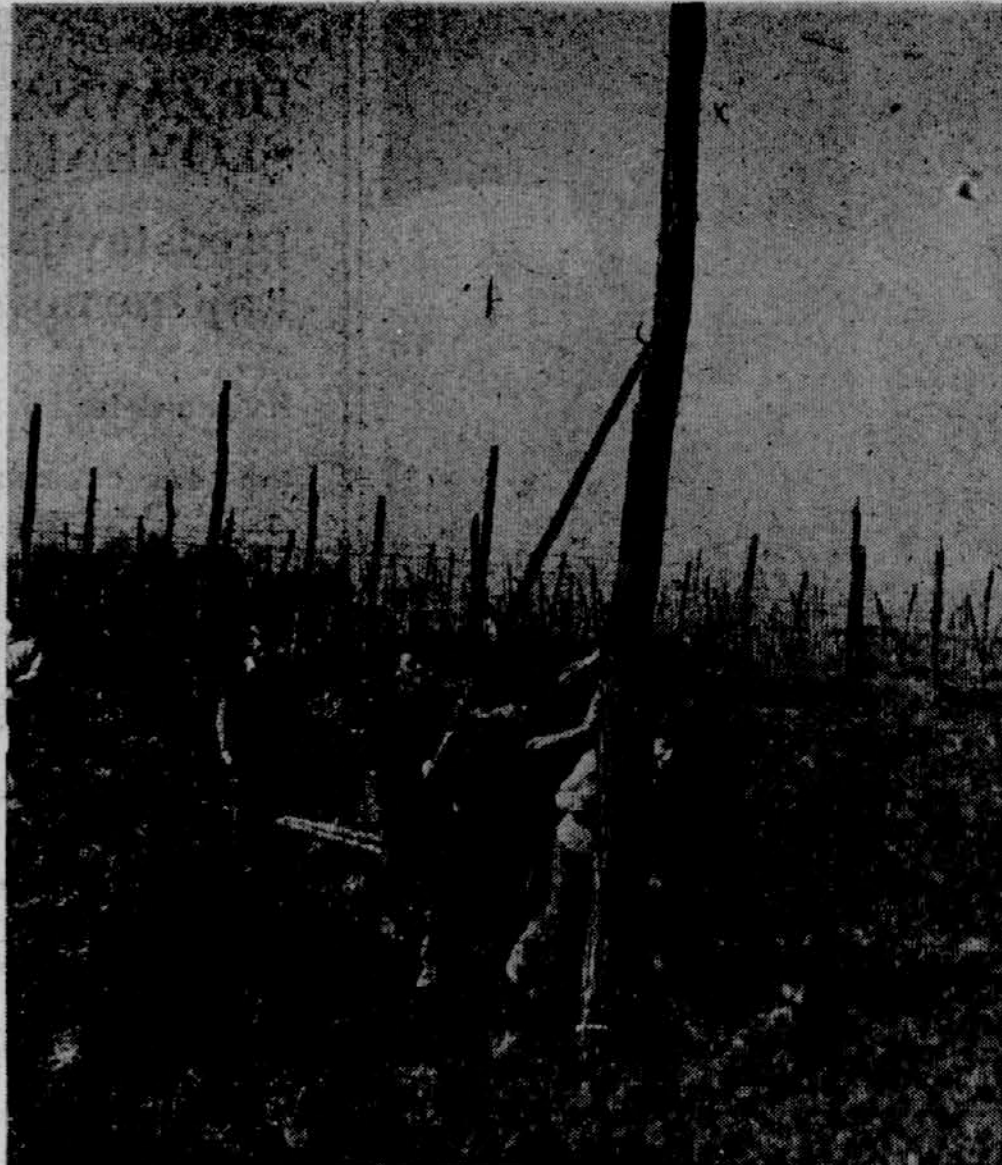
HMELSKE ZIONICE — Pri kmetijskem kombinatu Hmezd Zalec bodo letos na novo zgradili 107 ha hmeljskih žlic. Zaradi cenejših gradiv bodo postavili lesene opornike namesto betonskih. Posnetek je iz kompleksa pri Zalcu. Foto: T. Tavčar
