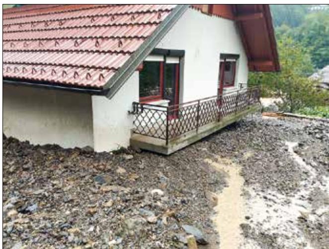
Stanovanjsko hišo je zasulo do zgornjih balkonov, teden dni kasneje so jo morali že porušiti. (Foto: Nejc Zager)
