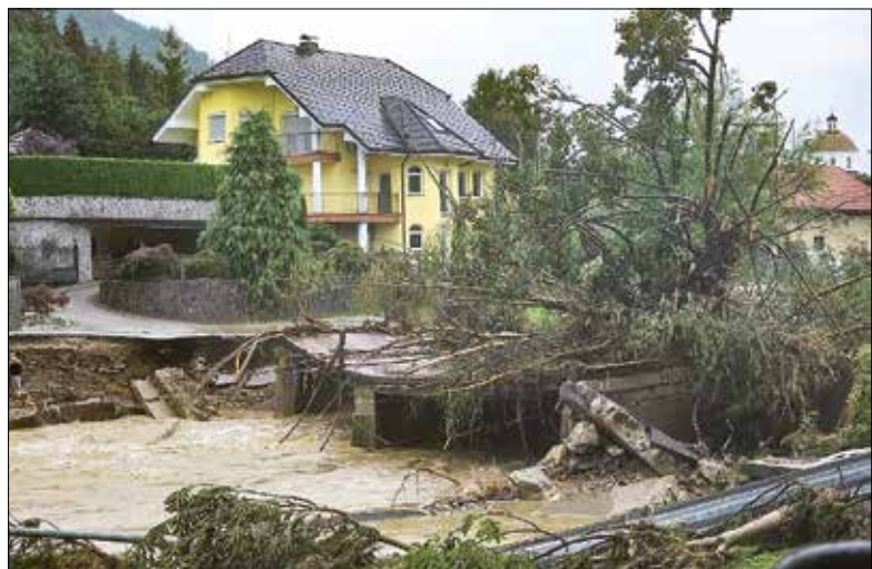
Poškodovanih je veliko mostov, nekaj jih je odneslo.
