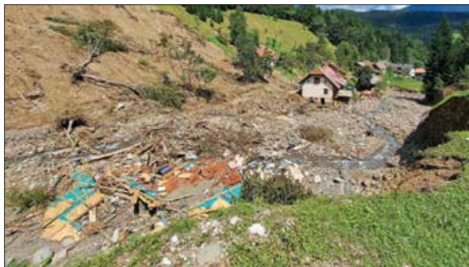
Na tem mestu je v Trbižu stala stanovanjska hiša, dokler je ni odnesel plaz. (Foto: Franjo Atelšek)
