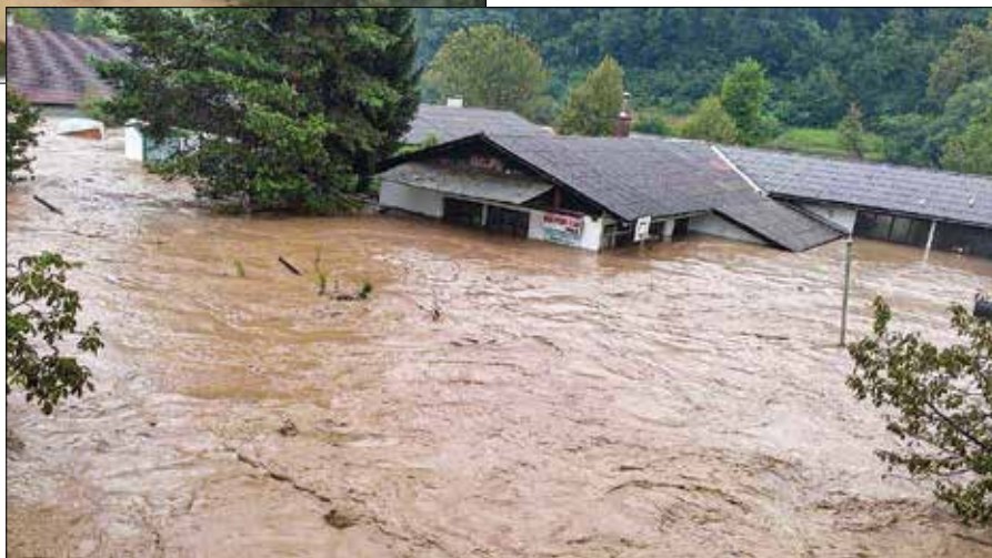
V Obrtniški ulici v Nazarjah so bili visoko poplavljeni vsi stanovanjski in poslovni objekti. (Foto: Matjaž Filčič)
