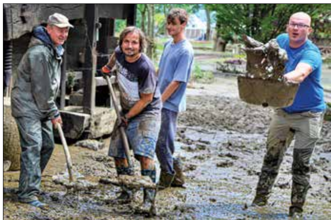
Prostovoljci v Mozirskem gaju odstranjujejo kot betonska malta lepljivo blato. (Foto: Jože Miklavc)
