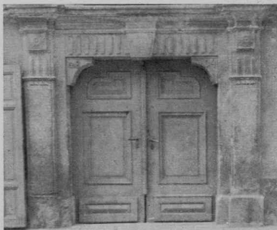
Sl. 4. Portal v Zidanškovi št. 17 z letnico 1804
