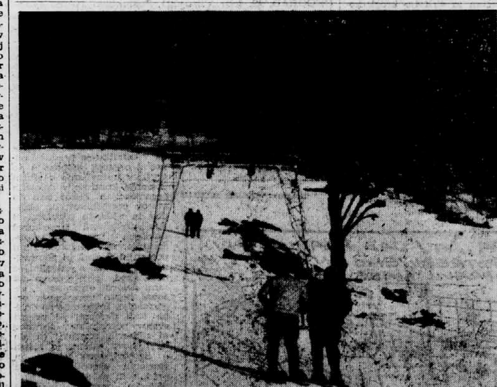
NOVI SMUČARSKI VLEČNICI NA LOKVAH IN NA LAZNAV — Po toliko prispevanjih so se naposled uredile želje turističnih delavcev na Boršnikem, predvsem pa ljubiteljev smučanja: obratovati sta začeli vlečnici na Lokvah in na Laznav. Na Lokvah je dolga 313 m, na Laznav pa 400 m; obe lahko prevažata v eni uri okrog 400 smučarjev. Obe napravi bodo uradno odprli jutri. Foto: A. Nemec
