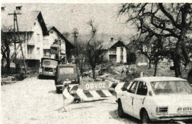
Zasip — Ker sta se naselji Rečica in Zasip v zadnjih letih precej povečali, je postala stara cesta preozka in preveč nevarna. Delavci obrtnega gradbenega podjetja Grad Bled jo širijo od mostu čez potok Rečica v smeri proti Zasipu. Pozneje jo bodo delavci Cestnega podjetja Kranj še asfaltirali. — Foto: B. B.
