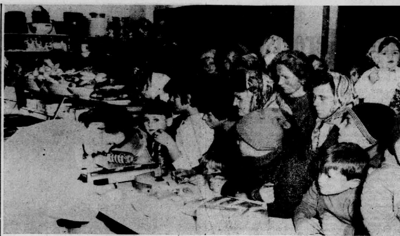
OB OTVORITVI TRGOVINE — Minulo soboto so v Vogljah ob praznovanju krajevnega praznika odprli nov objekt, v katerem so trgovina, zbiralnica mleka in društveni prostori. Zbrali so se številni vaščani, ki so z delom, materialom in denarjem pripomogli k težko pričakovani novogradnji. Foto: M. Kregar
