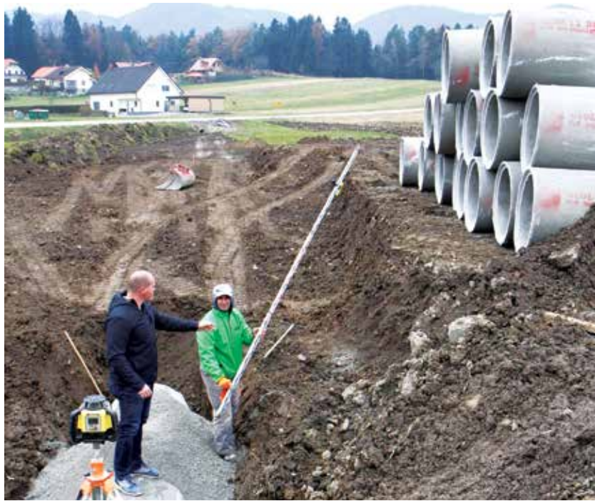
V zaselku Šmatevž pri gradnji drenažne kanalizacije
