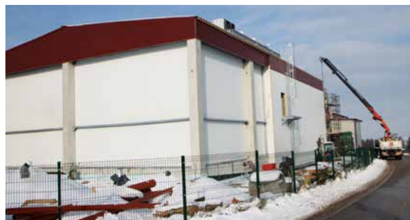
Gradnja novega objekta je kljub hladnemu vremenu v polnem teku.
