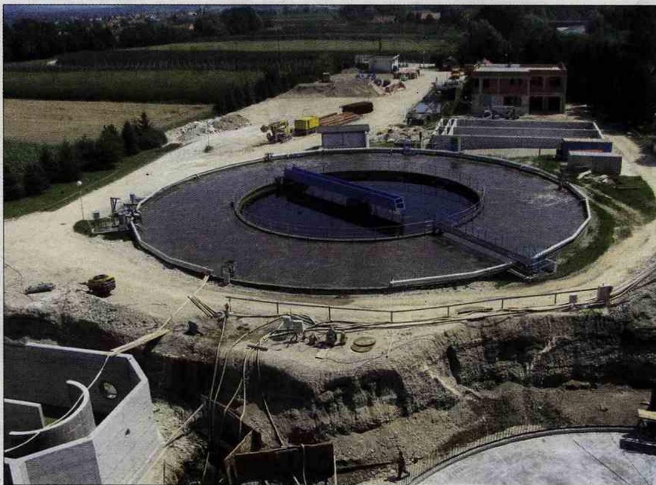
Gradnja čistilne naprave v Kasazah
