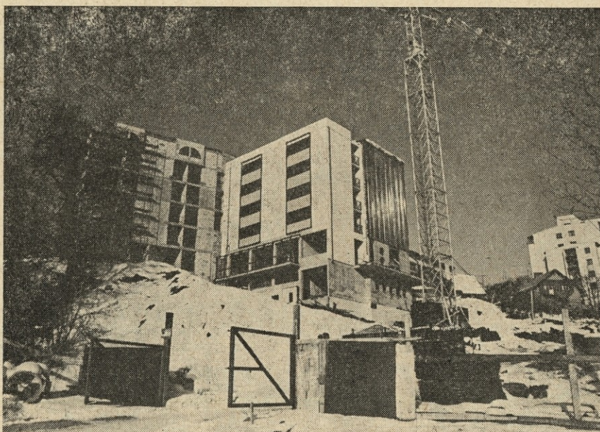
Dijaški dom v Hrastniku v zaključni fazi gradnje.
