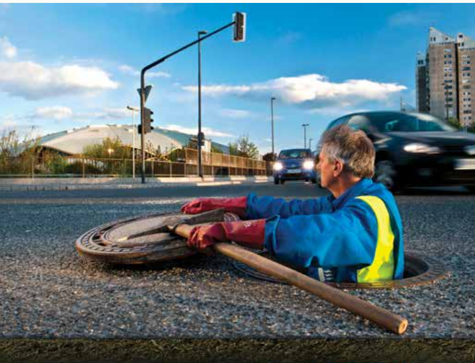
Delavca v kanalizacijskem jašku
