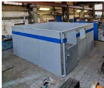
Nova kabina za delavce žerjavnega oddelka v Jeklarni, ki bo omogočala počitek na nivoju žerjavne proge.
