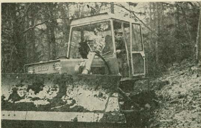
Buldožerist Ivan Ožir iz TOZD Gradnje reže v pobočje traktorsko vlako
