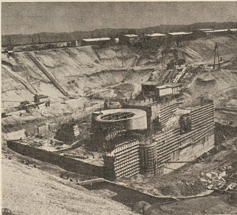
Na obeh agregatih bodoče HE Srednja Drava I sta sifonski oblogi že montirani in zabetonirani. Pri prvem agregatu pa je že nameščen leseni opaz za betoniranje spirale.
