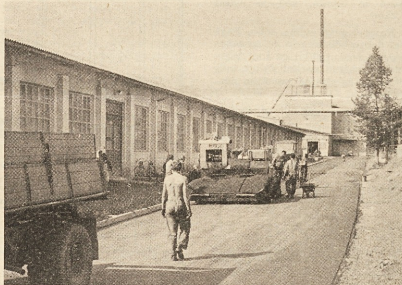
Asfaltiranje poti okrog TP Cerknica
