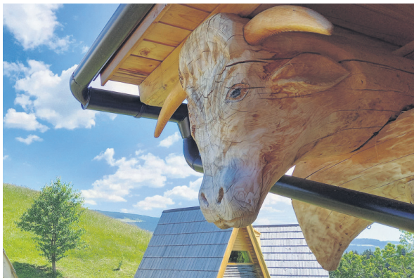
Jože je poskrbel za številne izrezljane podrobnosti. Bikova podoba krasi konec več kot dvajset metrov dolgega smrekovega hloda, ki služi za oporo streh.
