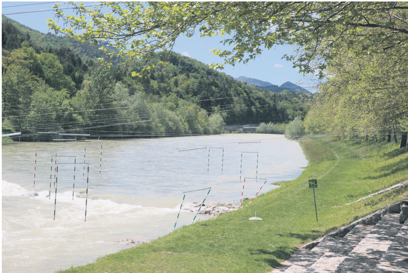
Približno sto metrov od Špice v Celju v smeri proti Žalcu je predvidena izgradnja brvi v okviru kolesarske povezave Celje – Žalec. (Foto: Andraž Purg - GrupA)
