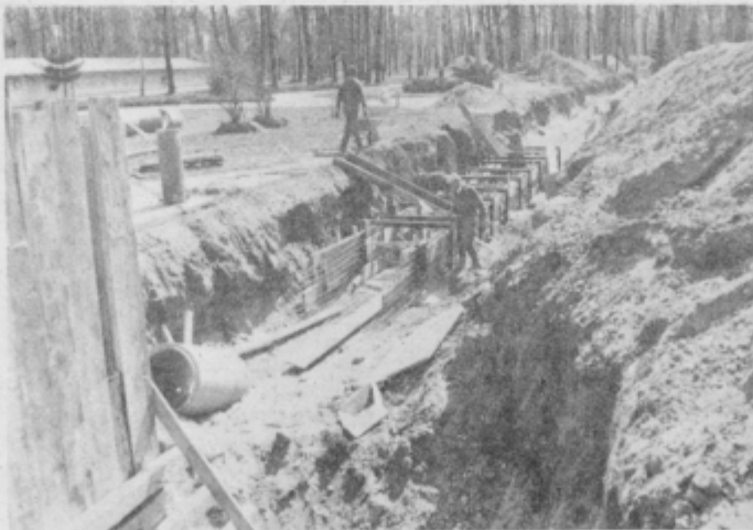
Naselje Kidričevo je te dni prepolovljeno zaradi del pri izgradnji magistralnega toplovoda. (foto: M. Ozmec)
