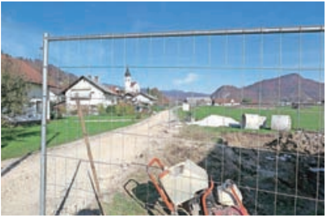
Obnova dvestometrskega odseka dotrajane ceste na severnem delu Podgorja / FOTO: JASNA PALADIN
