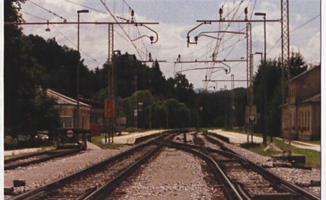
Pogled na železniško postajo na Ponikvi danes. Foto Tomaž Pritekelj
