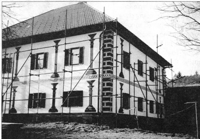
V okviru obnovitvenih del so se lotili tudi fasade
