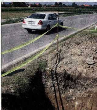
Izkopi na drugi strani ceste
