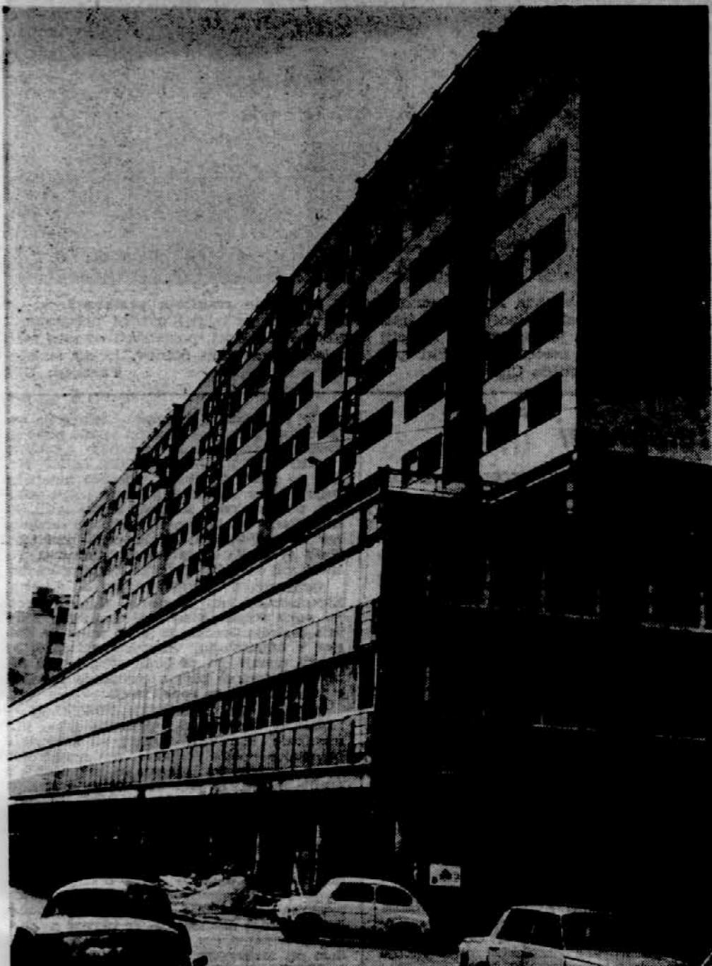
POSLOVNO STANOVANJSKI OBJEKT S TRGOVSKIMI LOKALI V GRADNJI UL. MOŠE PIJADE, LJUBLJANA, IZVAJALEC: SGP GROSUPLJE.
