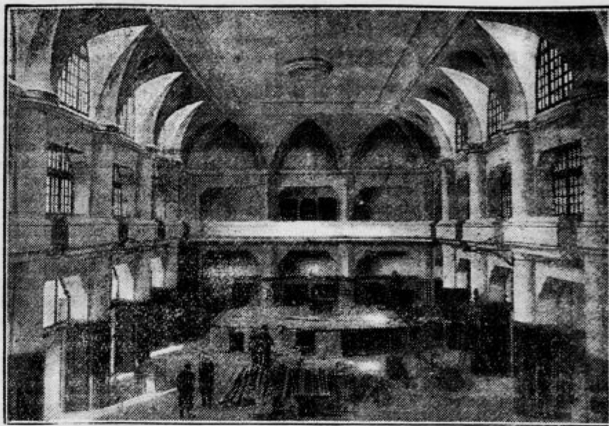
Velika dvorana na Taboru z galerije pred dovršitvijo.
