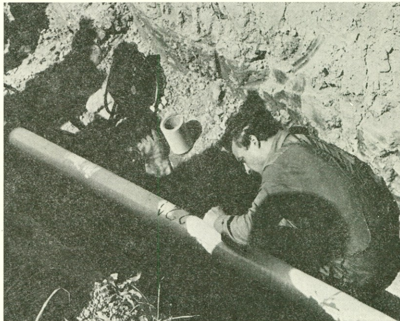
Dovodni plinovod ima premer 100 mm in dolžino 5300 metrov, razvod po mestu do potrošnikov pa je dolg 1600 metrov
