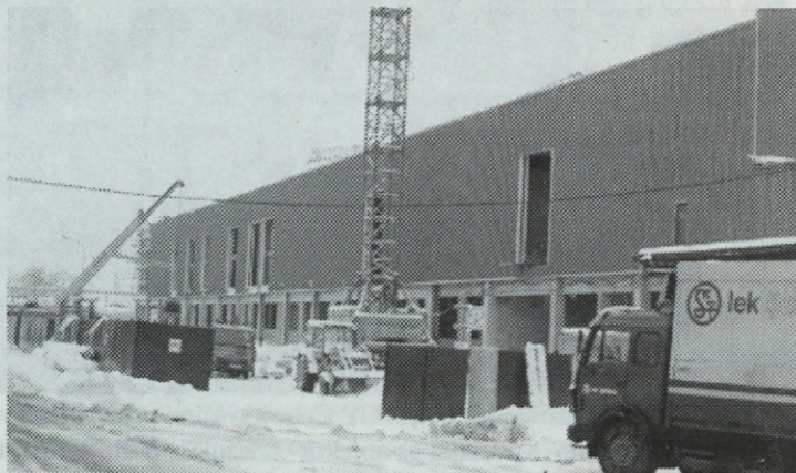
Stavba je že pod streho in zaprta, tako da lahko nadaljujejo z notranjimi deli.
