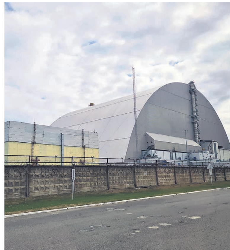
Jekleni sarkofag nad reaktorjem 4 naj bi pred sevanjem ščitil naslednjih sto let.
