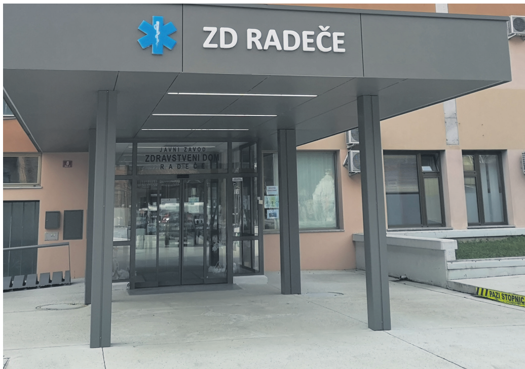
Za Zdravstveni dom Radeče, ki obeležuje 30 let samostojnega delovanja, bo letos največji naložbeni izziv celovita energetska obnova stavbe. (Foto: BA)
