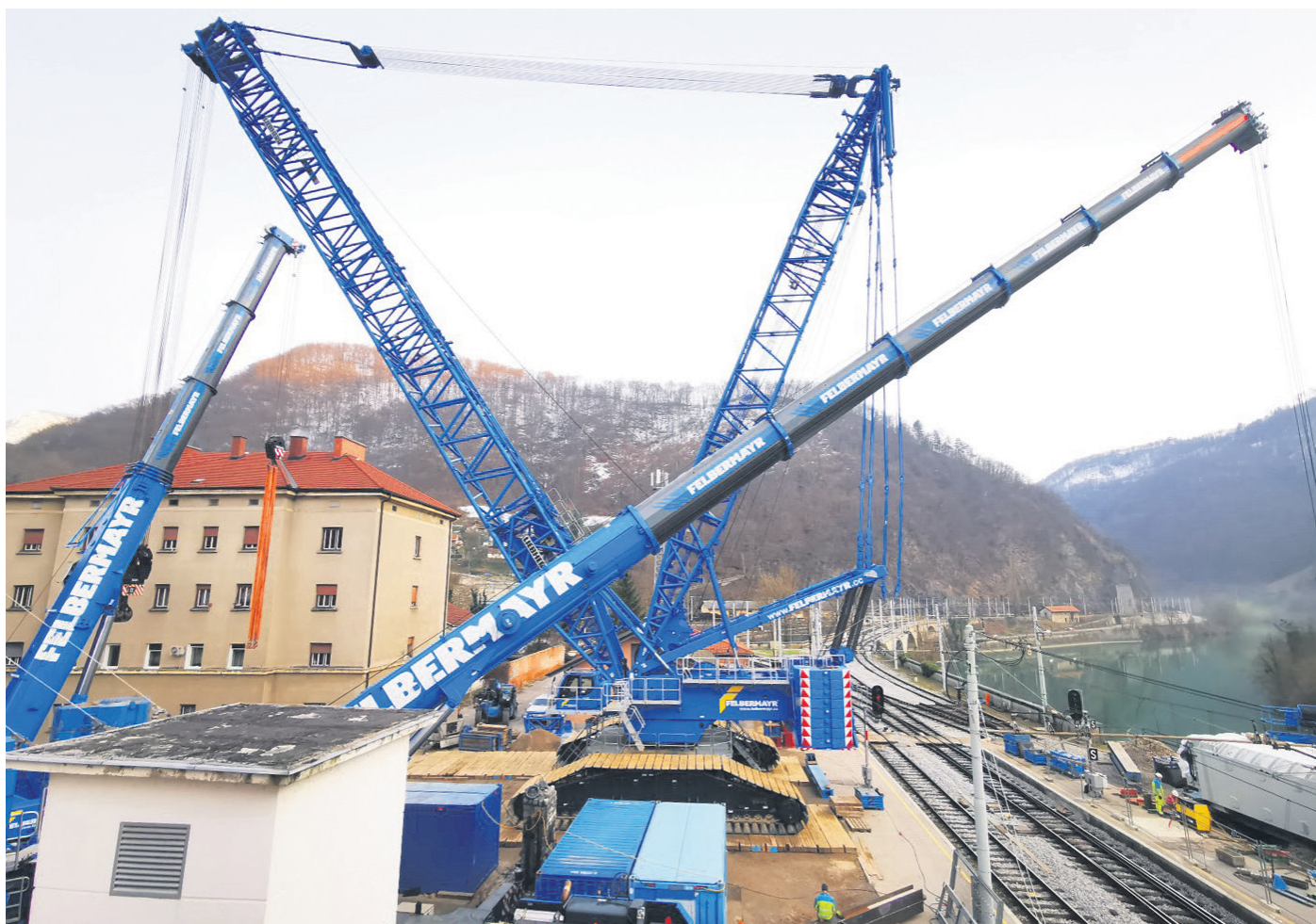
Dvigovanje prevrnjene transformatorske postaje je predstavljalo enega večjih zalogajev. Iz Avstrije so v ta namen pripeljali posebno tisočtonsko dvigalo. (Foto: FB Metal industry)
