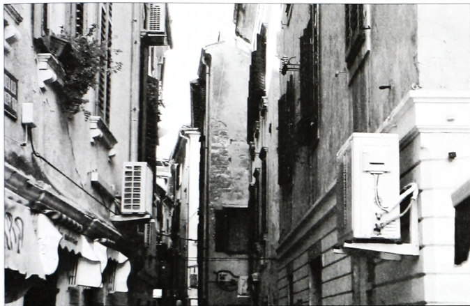
Nenadzorovano nameščanje klimatskih naprav na pročelja stavb je čedalje bolj nadležno. (foto: ss)
