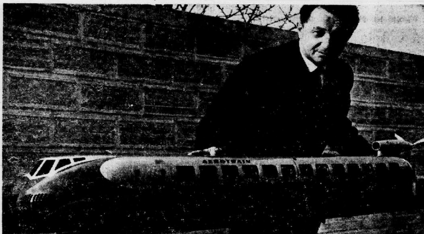
«AEROTRAIN», 400 km/h — V pariški četrti Colombes je pokazal francoski izumitelj Paul Guyenne (na sliki) model svojega «aerotraina», vlaka, ki bo zanj potrebna ena sama tirnica in bo vozil na tako imenovani zračni blazini. V vlaku, katerega model kaže posnetek, v zadnjem delu je propeler, podoben letalskemu — bo prostora za sto potnikov. O svojem «aerotrainu» (zračnem vlaku), ki se zanj zanimajo francoske državne železnice, pravi izumitelj Guyenne, da bo zmogel hitrost do 400 km na uro.
