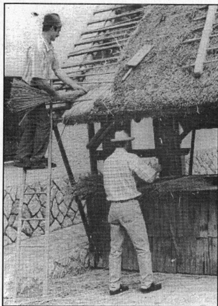
Od štanta do štanta: takole so nekdanj krili strehe...
