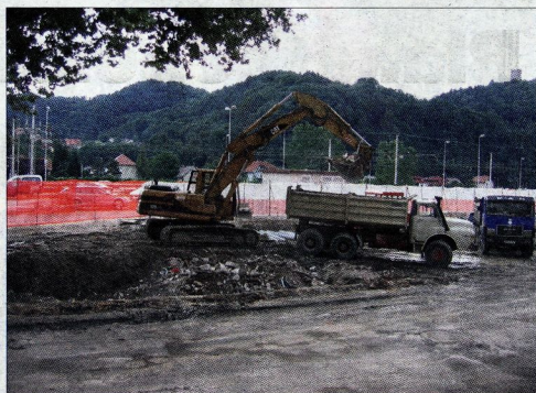
In takole so na kamion nalagali še zadnje ostanke paviliona in jih vozili na komunalno deponijo. (Foto: BS)
