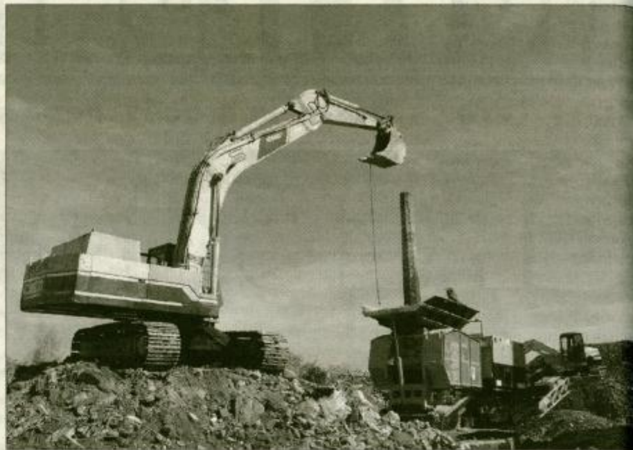
Stavbe na območju Stare cinkarne ruši koroški podjetnik Slemenšek.
