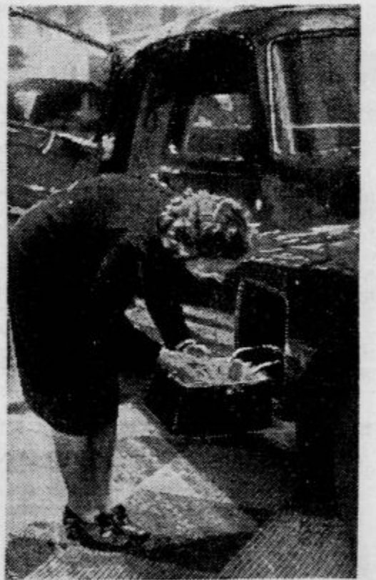
Na razstavi avtomobilov v Berlinu vidijo obiskovalci razveljavljeno novost. Pod sprednjim blatnikom je nameščen rezervoar s vodo, da si vozač lahko umije roke
