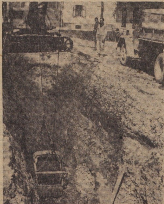
GRADNJA KANALIZACIJE V SAVLJAH GRE H KRAJU — Pri podjetju Kanalizacija so nam zatrčili, da bodo do konca meseca z deli v glavnem končali. Deljali so še, da bo potrebno nekoliko počakati, da se bo cesta utrdila, poleg pa bo morala občina prekrbeti sredstva za ureditev cestišča...
