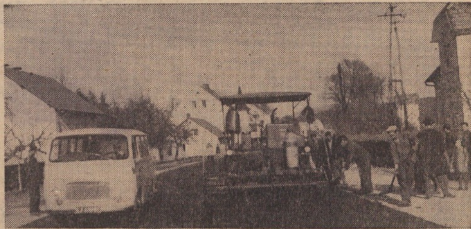
ASFALTIRANJE CESTE NA ČRNUCAH
