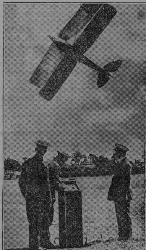
Na Angleškem preizkušajo letala, ki se dajo voditi v višini 3000 m in 16 km od kontrolne postaje brezčim potom in brez pilota.
