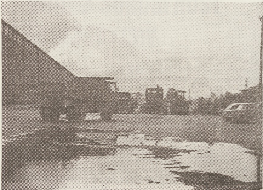
K sodobni tehnologiji v gradbeništvu spada tudi sodobna mehanizacija
