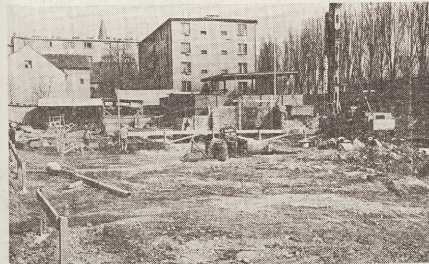
In tu bo stala nova stanovanjska poslovna stavba, ki so jo pričeli graditi
