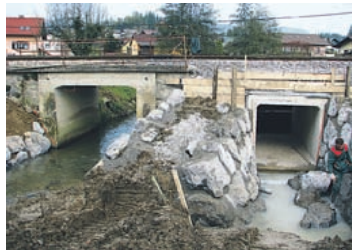
Izgradnja prepusta z razbremenilnim kanalom na Toplici v Pohrastniku
