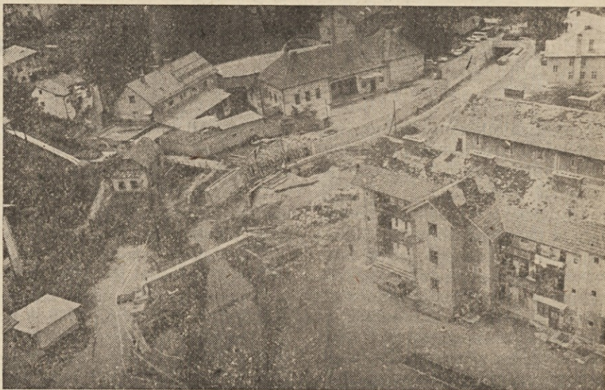
V teku so obsežna regulacijska dela na potoku Trboveljščica na Trgu svobode, neposredno ob stari rudarski stanovanjski koloniji Njiva.
