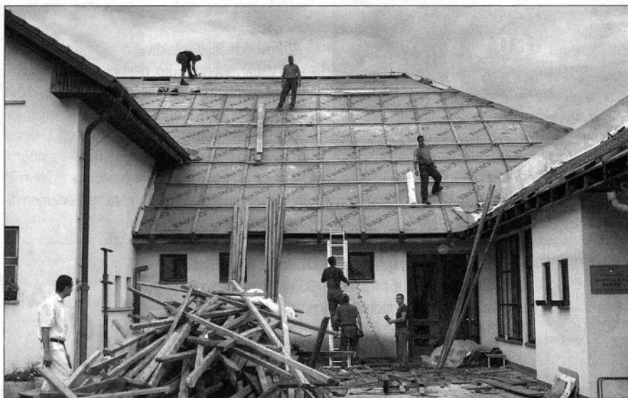
V Šmartnem ob Dreti so na novo prekrili vrtec in vezni del do večnamenske dvorane (foto: Marija Lebar)
