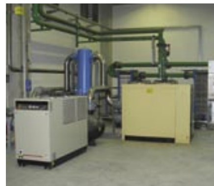
Hladilniška sušilnika in vodni hladilni sistem
