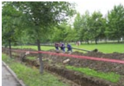
Obnova omrežja pitne vode
