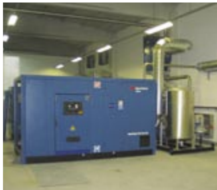
Novi kompresor in adsorpcijski sušilnik
