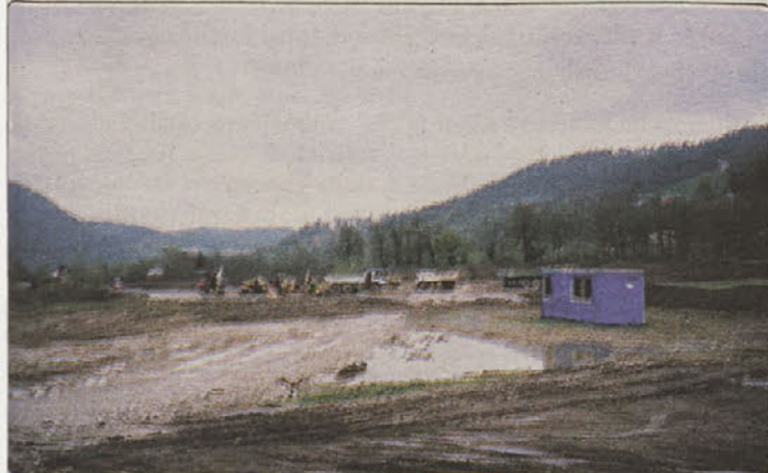
Kljub prepričanju so se pripravljala dela za HE Boštanj začela. Nekdaj rodovitna ravnica je postala gradbišče...
