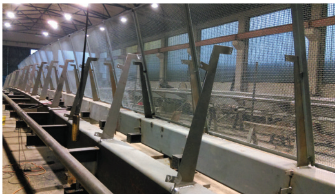
Slika 10 • Izdelava konstrukcije mostu v delavnici.
