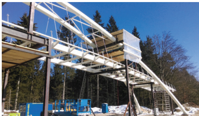
Slika 11 • Sestavljanje mostu ob avtocesti.
