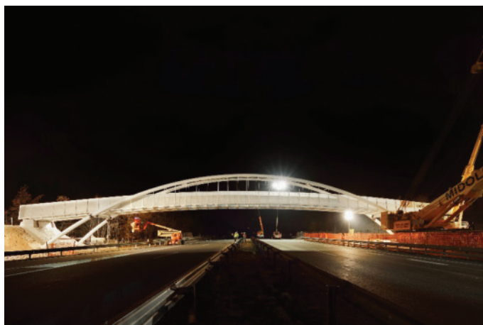
Slika 12 • Nočni dvig mostu. (Foto: M. Kambič)
