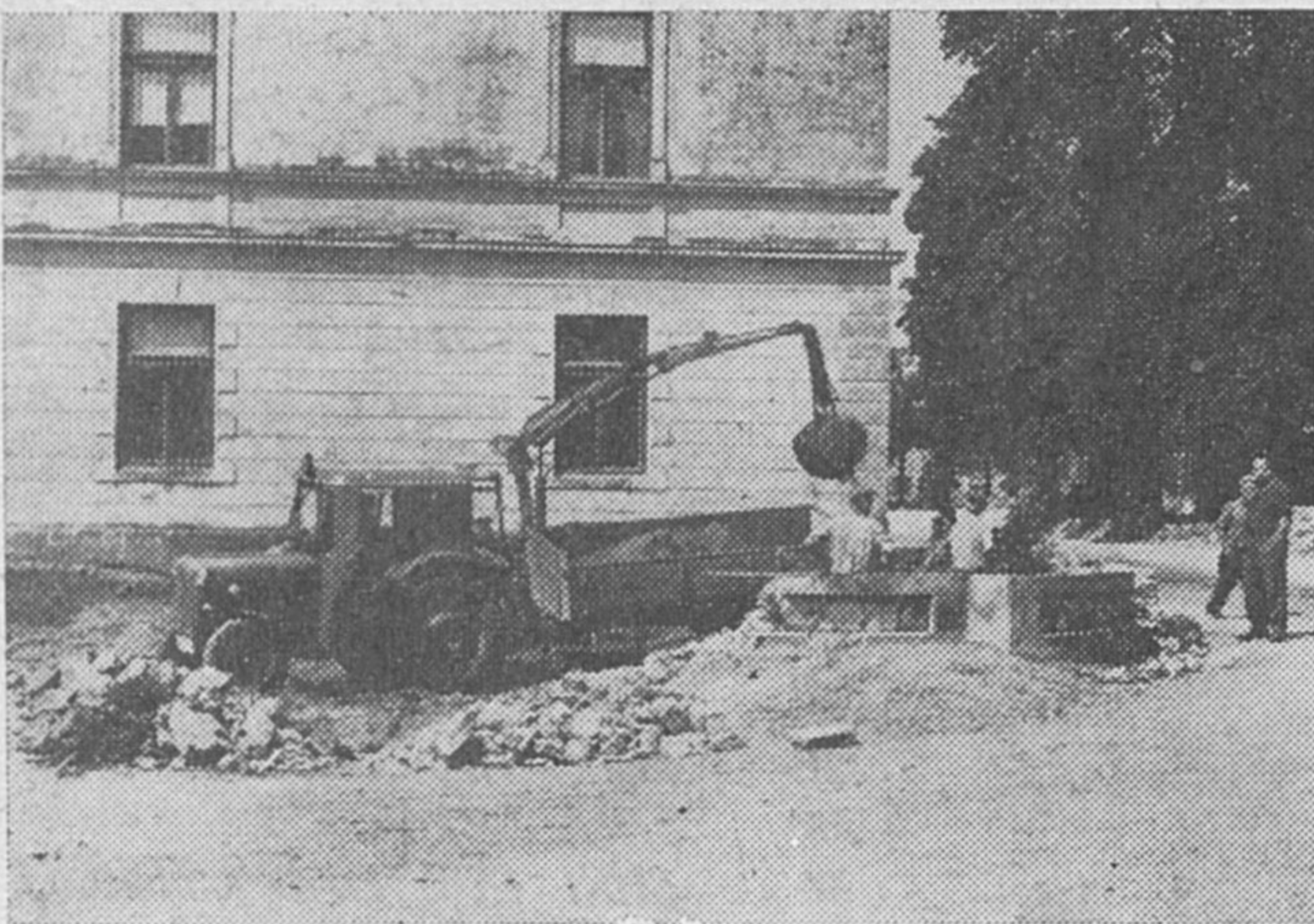
Razčiščevanje važnega prometnega križišča pred novo zgrajenim blokom GG v Cerknici
