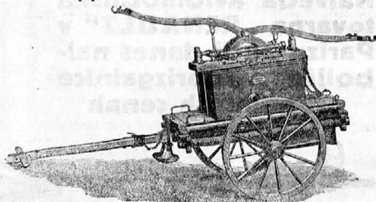
Snemalna brizgalnica z dvema curkoma, v treh velikostih: od 200 - 355 2 /min.
